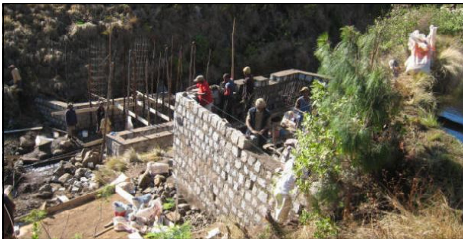
Ottobre 2010: lavori di costruzione del ponte di Sarodroa
