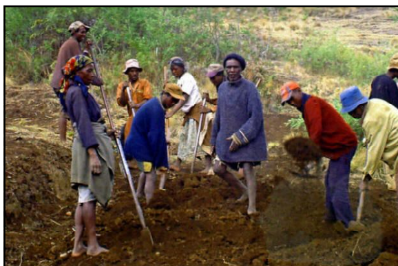
Ottobre 2010: lavori di costruzione del ponte di Sarodroa
