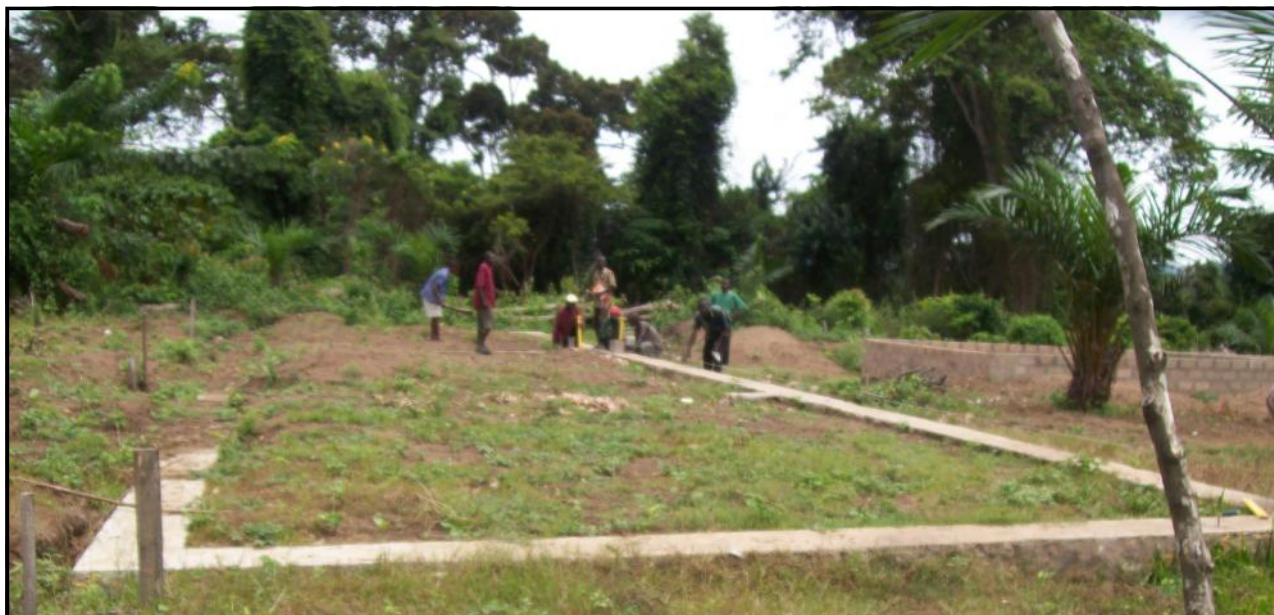
2010. Costruzione delle fondamenta del primo edificio
